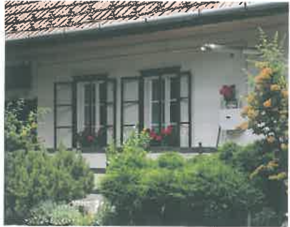
régi épületek hagyományos ablakai
