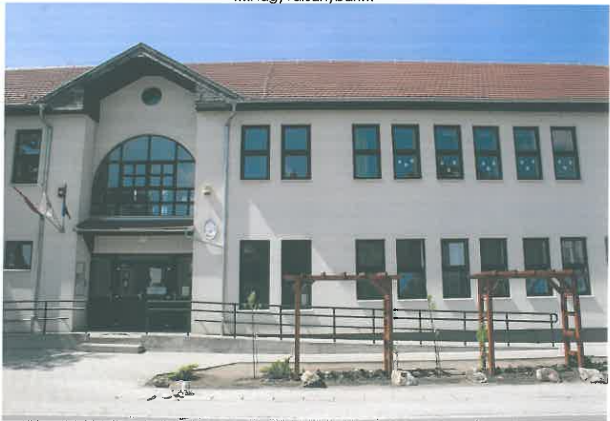
...az álló, hosszúkás ablakrend az általános iskola új épületén a rendezettséget jelképezi, az építészeti eszközökkel és ablakkialakítással, eldőtől, tetőzettel hangsúlyozott kapuzat a főbejáratot emeli ki.
