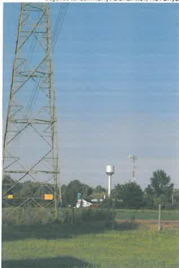
Sajátos létesítmények a város szélén: magasfeszültségű távvezeték, víztorony, mobilantenna-torony és a zöldbeágyazottan benzinkút
