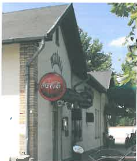
Bakterház Pizzéria és Virágbolt (volt vasúti épület) Szent István tér 1.
