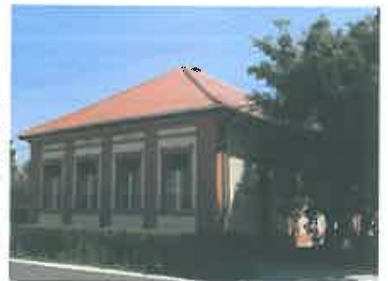
...a régi „elemi iskola” épülete
