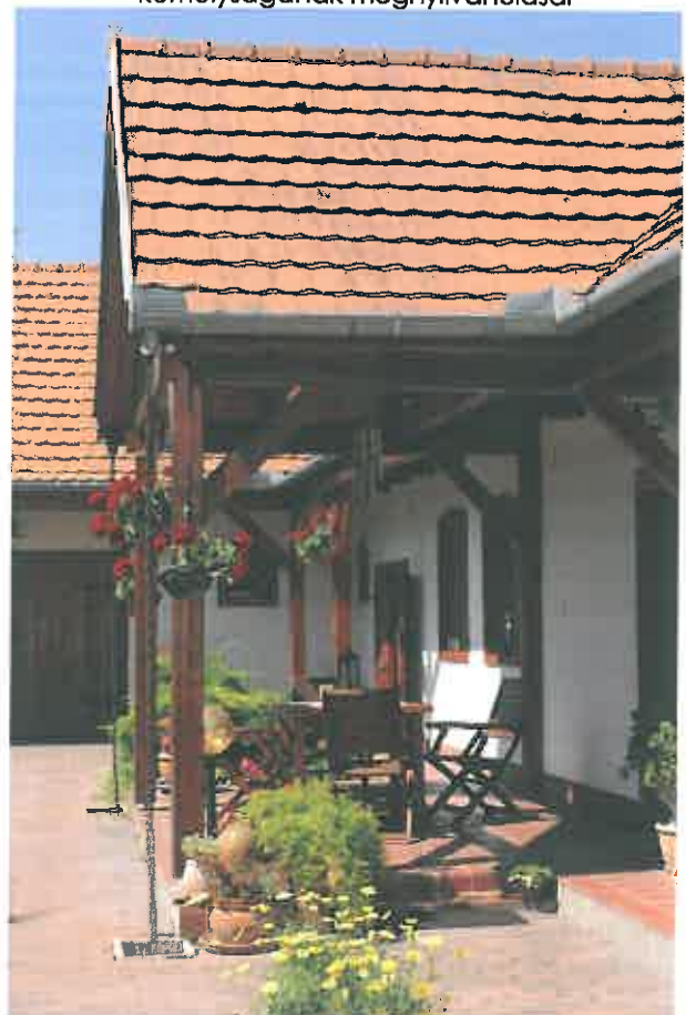
Az épületbővítéssel felújított régi parasztház fedett terasza szellemes, finom, alig észrevehető, tető-vízvezetési megoldását érdemes alkalmazni!
