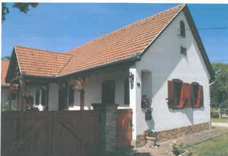
Sport utca 49., az 1912-ben épült „hosszúház” felújítása - a ház mai igények szerinti kibővítésével – példaértékű. Az újra fogalmazott építészeti elemek, formai megoldások beleolvadnak a régiekhez, egységes egészet alkotva.
