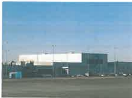
...Dunavarsány Ipari Park az 51-es főút felől nézve, az IBIDEN főépülettel...
