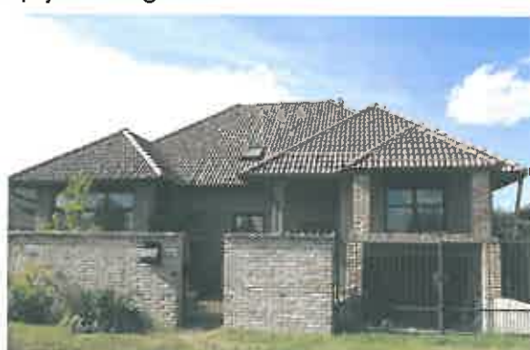
Rusztikus téglakerítés mögött önmagát részben elrejtő, részben megmutató mozgalmas, izgalmas teksztűrájú tetőzettel, mégis nyugodtságot árasztó lakóépület, az utcai homlokzatsíktól hátrahúzott, árnyékban „rejtőzködő” garázskapuval. A kerítés téglá anyaga a házon is visszaköszön. Az épület homlokzati színezése vélhetően még nem befejezett.
