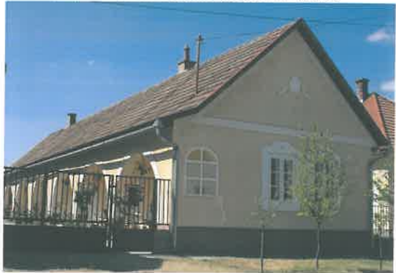
Nagyvarsány, Templom utca 29., kivételes példa az íves kialakítású tornác, az utcai bajárata ablakkal beépítve
